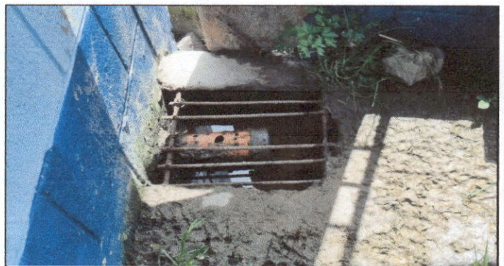
Foto 6: sustitución de tubería de agua pluvial de 6"
